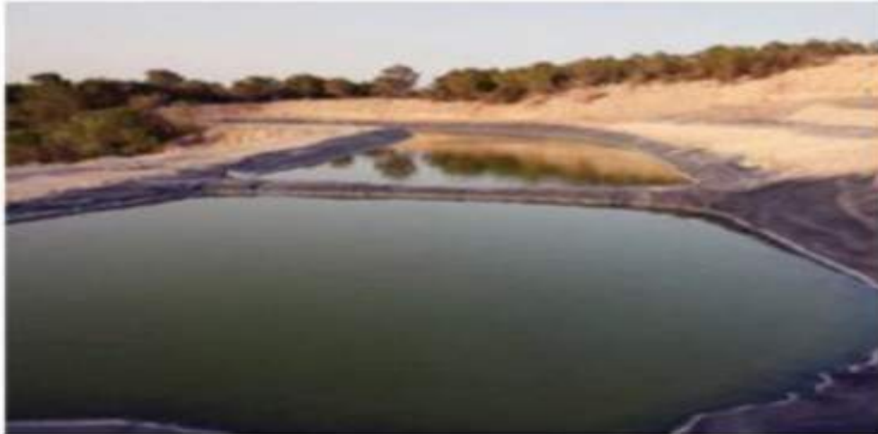
Bassin des eaux usées traitées
