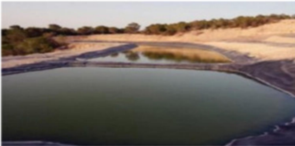
Bassin des eaux usées traitées
