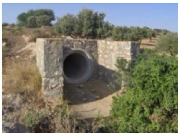
FIGURE 26 : CONDUITE DE SURVERSE EXISTANTE
