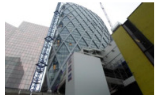
Chantier de la tour D2 Paris-France
