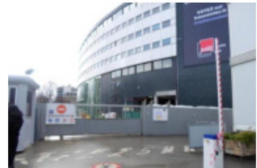
Chantier de la maison de la Radio Paris-France
